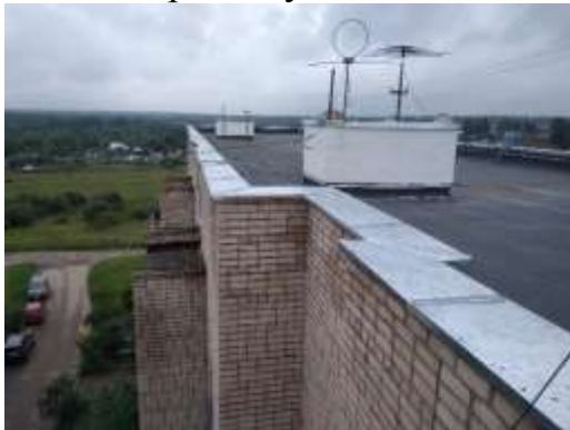
Ремонт крыши ул. Юбилейная д.27
