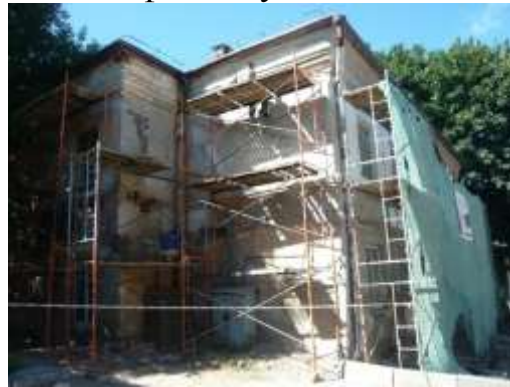
Ремонт фасада ул. Ленина д.8
